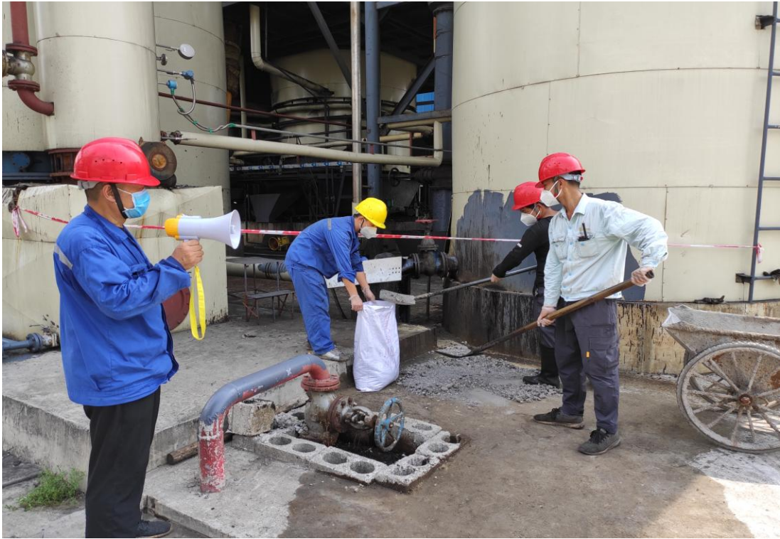
抢险组把吸附煤焦油的煤渣回收放入带内衬的包装袋中
