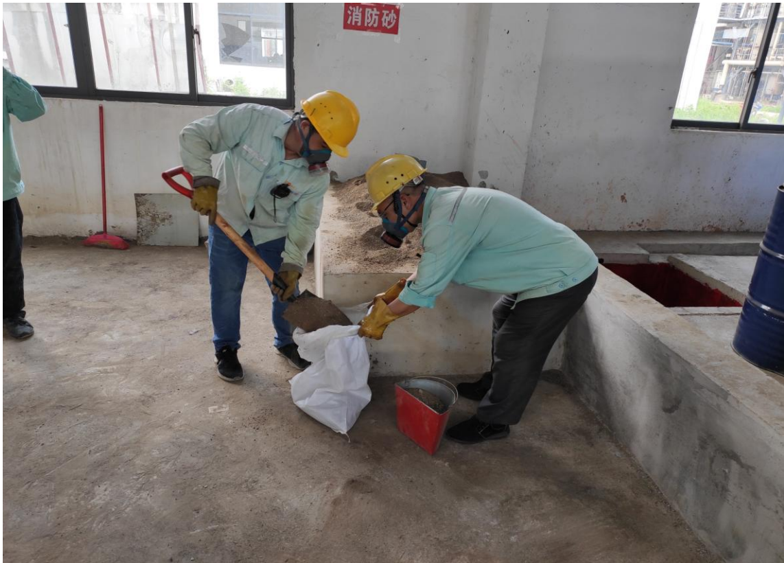
抢险组盛装砂土用于堵截泄漏物料
