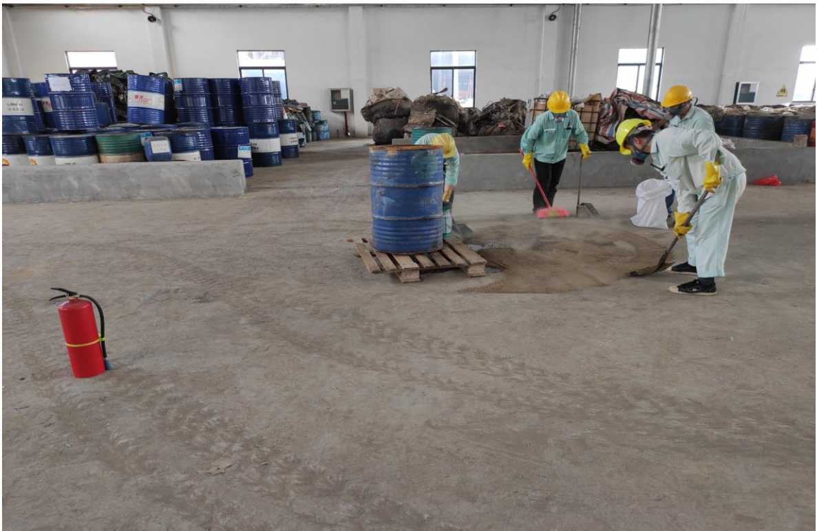
后勤组协助抢险组，把泄漏物连砂土一起装入带内衬的蛇皮袋中回收
