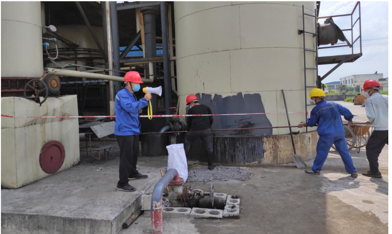
抢险组用煤渣吸附煤焦油，疏通焦油管道、消除故障
